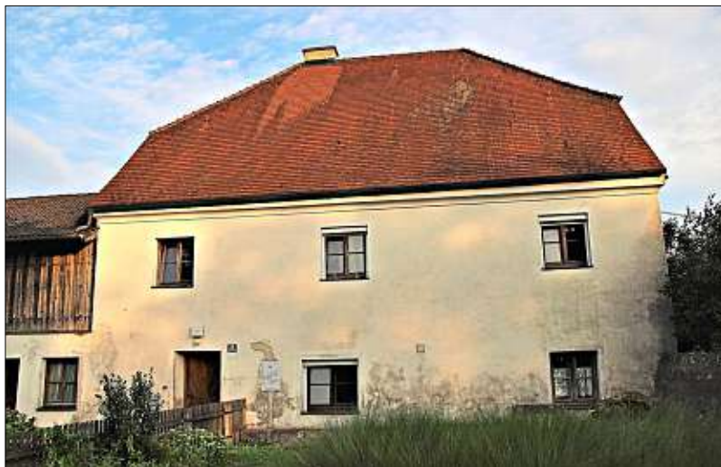
Das heruntergewirtschaftete Mesnerhaus und die Außenanlagen werden im nächsten Jahr erneuert.
